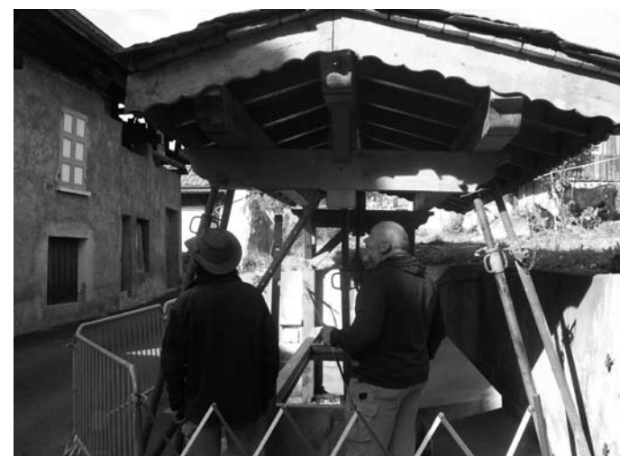
Consolidation des toitures de bassin
