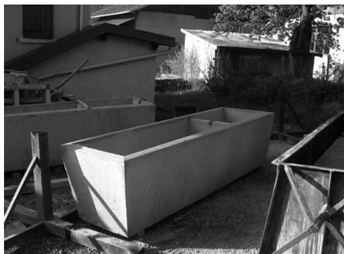
Fabrication de bassins
