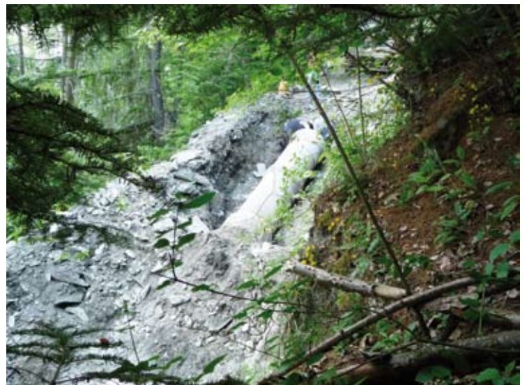
Buzage du ruisseau de l'ancienne route de Montorlin à Combe Noire
