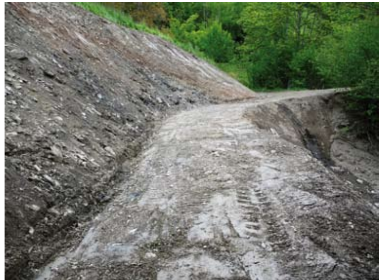
Remise en état de l'accès Le Villard/Le Rocherey
