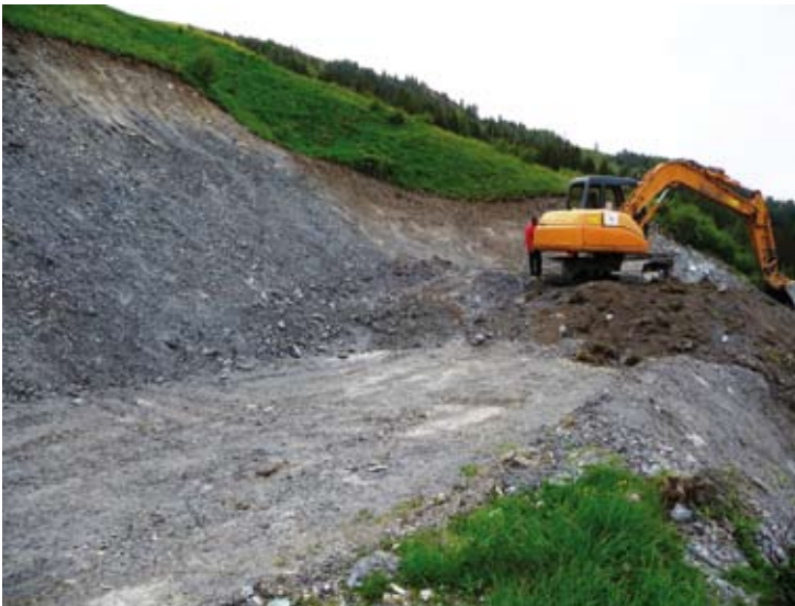
Travaux de route : reprise de l'accès au chalet du Carroley
