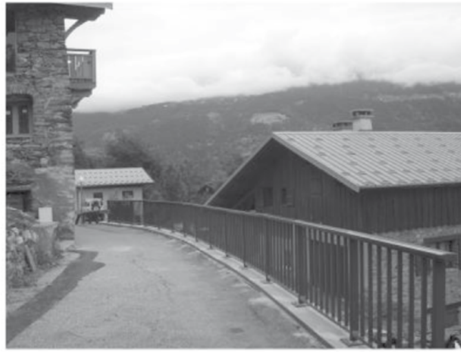
Garde corps au Villard
