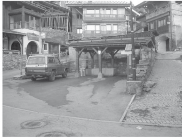
Rénovation place du Bassin à Montchavin
