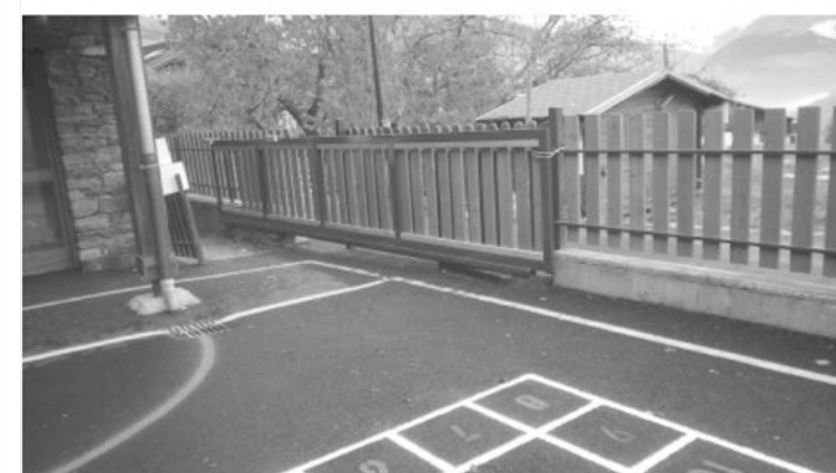
Rénovation cours de l'école de montchavin
