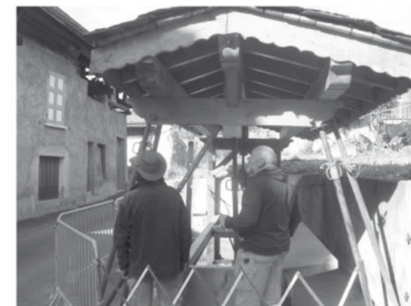
Reprise toiture bassin Chef Lieu
