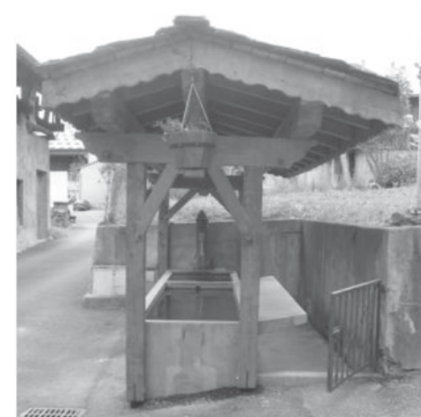
Reprise toiture Chef Lieu
