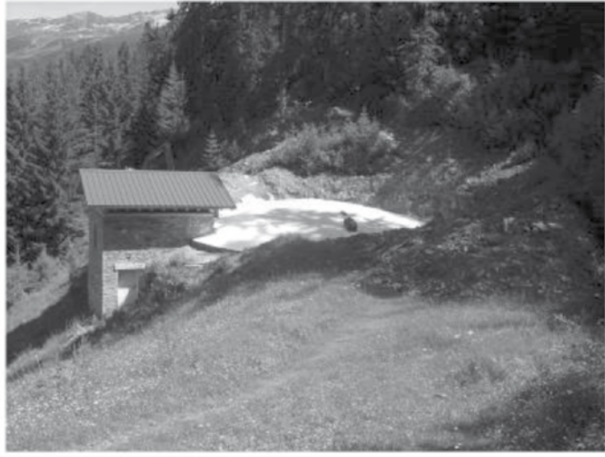
Pose d'une étanchéité sur la coupole du réservoir du Chanton
