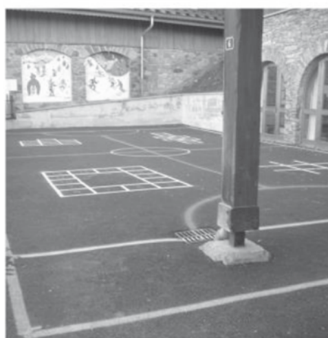
Rénovation cours de l'école de Montchavin
