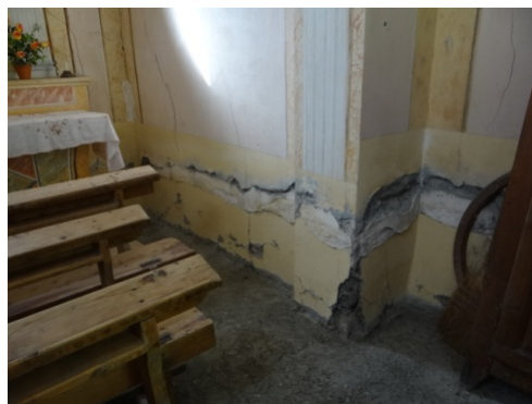
Construction sur lattis bois.
