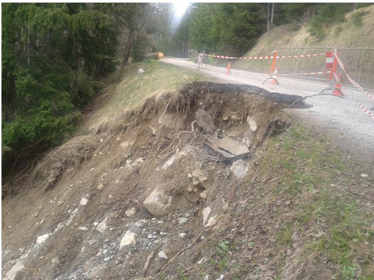
Le vendredi 19 avril dernier, la route de la Montagne a dû être fermée à la circulation pour des raisons de sécurité, en amont du chalet des Consorts PELLICIER, à Chantemouche, et ce, du fait d'un éboulement d'une partie de la chaussée survenu la veille.
