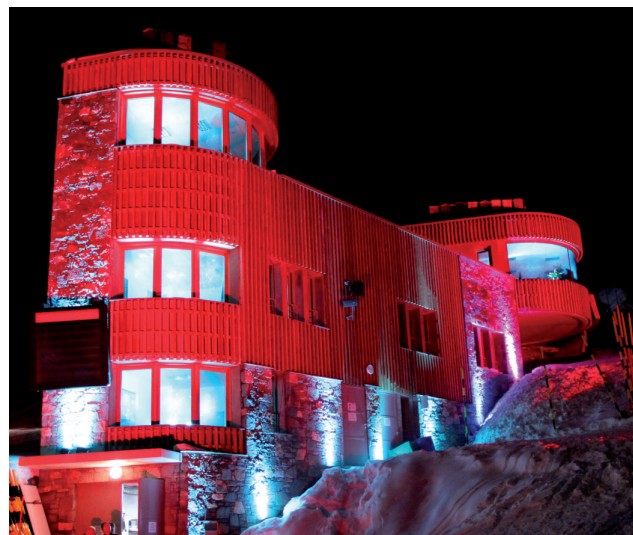
NOUVEAU BÂTIMENT DE CHRONOMÉTRAGE DU STADE DE PLAGNE CENTRE
