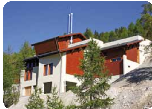
La chaufferie Biomasse à Plagne Centre est un exemple en termes d'énergie renouvelable
