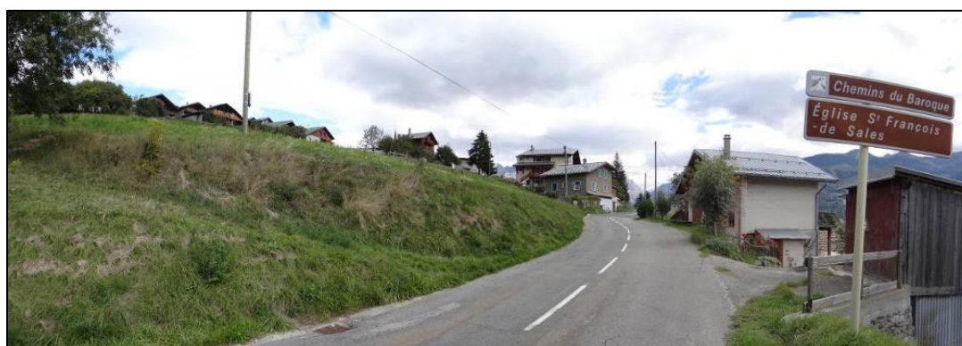
Photo 40 : Entrée Ouest du village de Valezan par la RD 86
