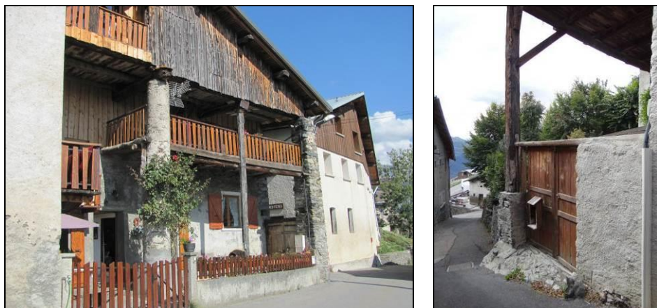
Photo 46 : Piliers et poteaux de soutien des avant-toits
