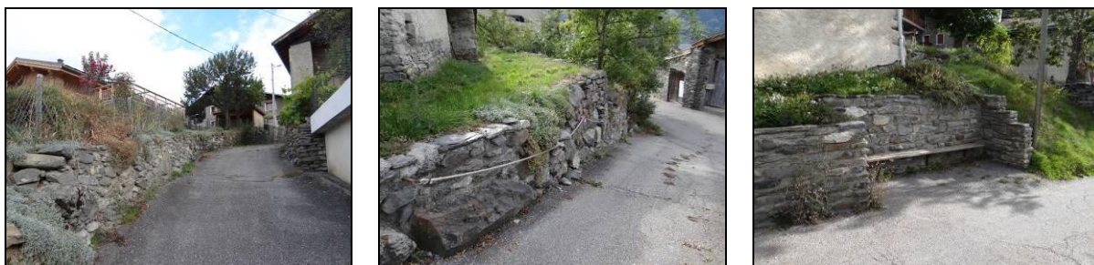
Photo 10 : Murs de soutènement dans le village
