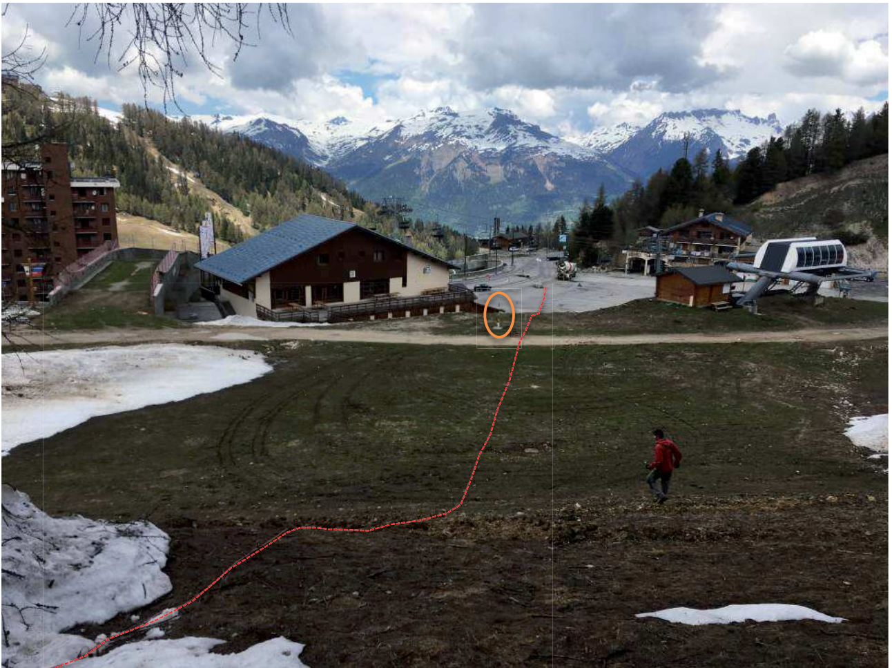
Figure 3 : Photographie du site d'étude prise le 18/05/2018 en direction du nord-ouest (vers l'aval). Le panneau électrique PE1 est indiqué par les pointillés rouges. Un regard de réseau enterré est entouré en orange, à l'aval immédiat de la piste 4x4.
