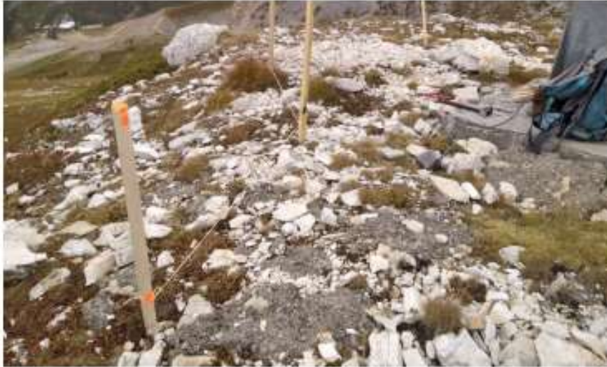
Mise en place de cordeline_ KARUM
