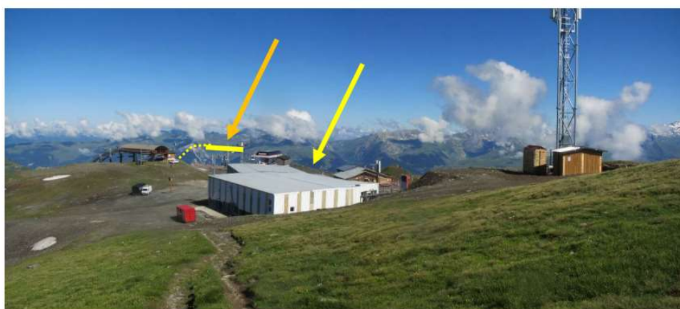
Pointage jaune : le bâtiment actuel. Pointage orange le positionnement de la gare d'arrivée plus conventionnelle de type télésiège, du futur projet, la fonction garage sera reléguée au niveau de la gare intermédiaire proche du col de Forcle.
