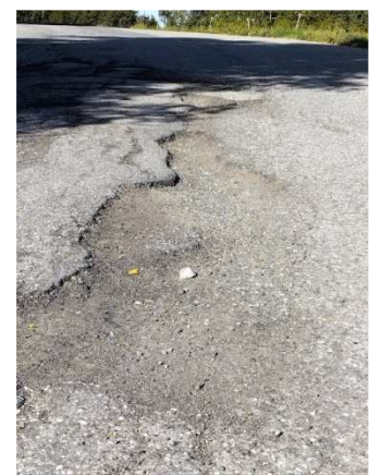
Route de la vallée des plain Bauches été 2023 8-10cm d'écart de bitume Secteur dangereux
