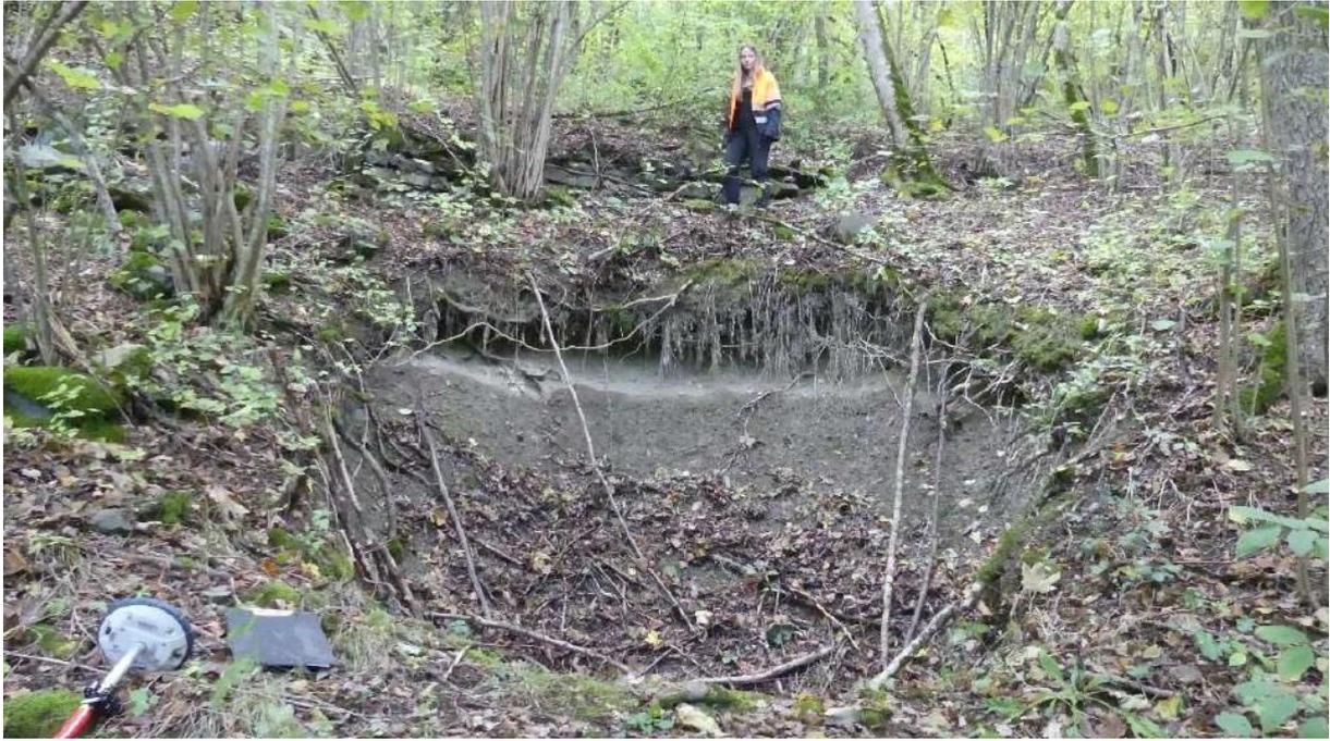
Photo 14 : Vue de l'effondrement dans l'axe de la galerie Hélène (D2)
