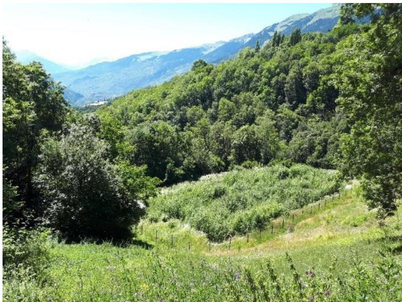
Elle permet de traiter les effluents de la commune déléguée de Valzean. Mise en service le 01/10/2019, elle est constituée d'un filtre planté de roseaux à un étage. Sa capacité nominale est de 400 EH (24 kg DBO<sub>5</sub>/j). Le débit de référence retenu est de 60 m<sup>3</sup>/jour ( $Q_{\text{pointe}} = 7,5 \text{ m}^3/\text{h}$ ).
