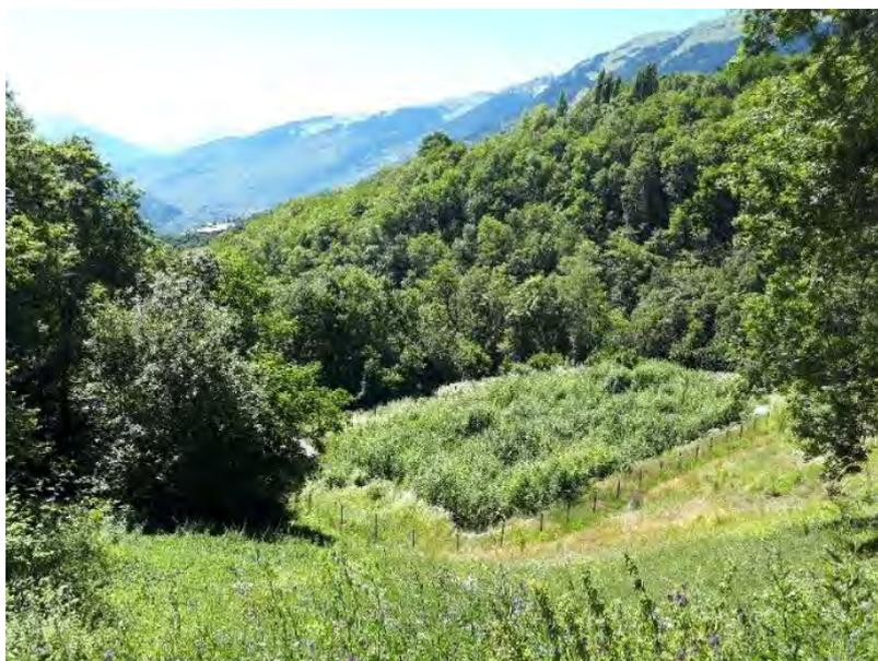
Elle permet de traiter les effluents de la commune déléguée de Valzean. Mise en service le 01/10/2019, elle est constituée d'un filtre planté de roseaux à un étage. Sa capacité nominale est de 400 EH (24 kg DBO<sub>5</sub>/j). Le débit de référence retenu est de 60 m<sup>3</sup>/jour (Q<sub>pointe</sub> = 7,5 m<sup>3</sup>/h).
