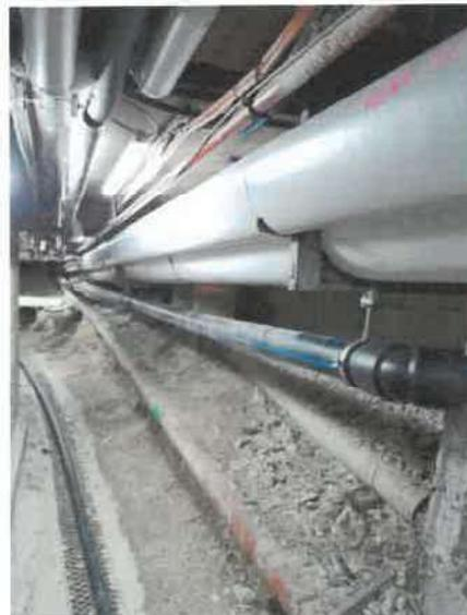
Tranche 2 : Pose d'une fonte de 125 VI sur 220 ml entre le Boulevard et la Cemrais. Cette réalisation nous a contraint à déplacer l'ilotage du hameau de la forêt en créant un regard avec un accès hivernal près du PI n°10. Une alimentation électrique d'une soixantaine de mètres a dû être tirée depuis la télésiégi du France. ECHM a réalisé le montage des pièces hydrauliques dans les chambres de vannes ainsi que les différents raccordements.
