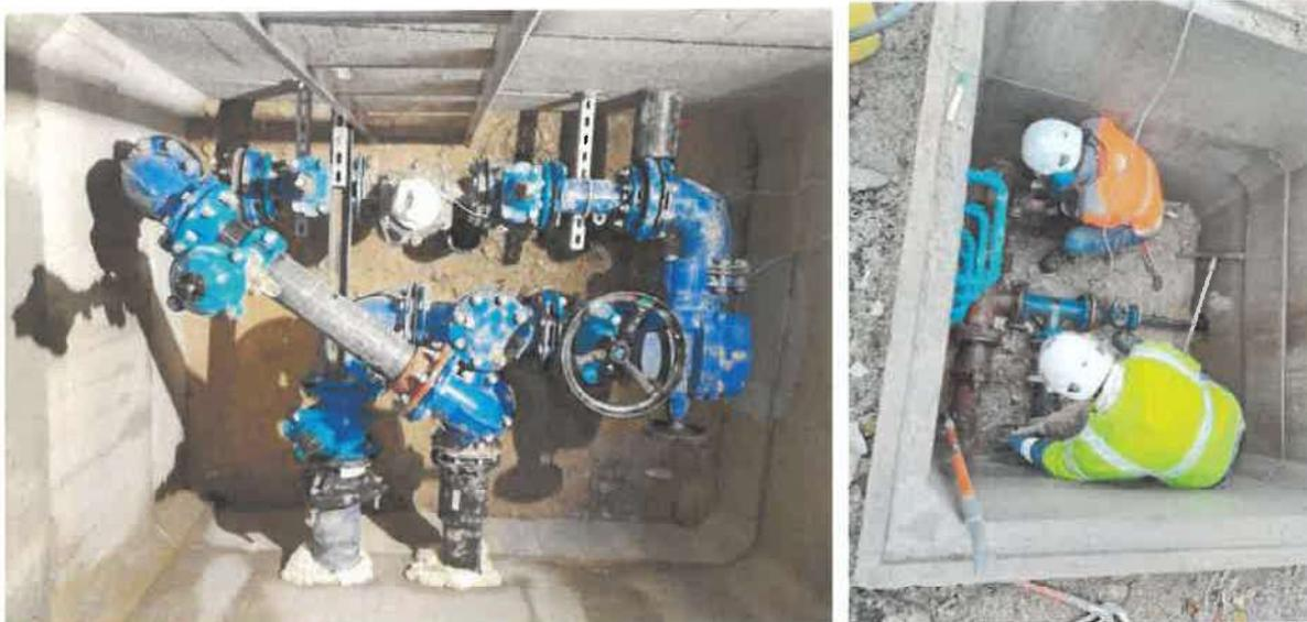
Le SIGP a financé le renouvellement de la canalisation fuyarde de transport de CO2 entre le Carlina et l'usine de reminéralisation (environ 650ml). ECHM a réalisé le suivi et la maîtrise d'œuvre et les raccordements de ce chantier.
