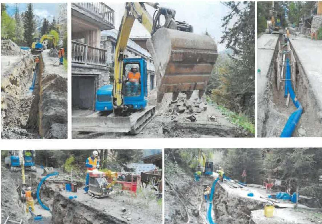
Nous avons repris avec un nouveau tracé la totalité du branchement AEP du bâtiment Digital à la Plagne 1800. Un regard de branchement a été ajouté afin de supprimer la BAC et permettre l'ajout de 2 vannes de sectionnement.
