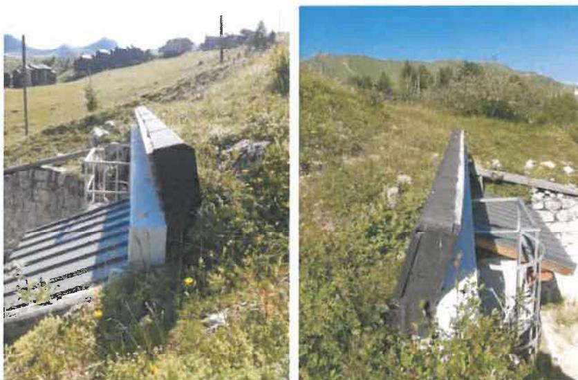
Renouveler les résines d'étanchéité des cuves 400 m<sup>3</sup> des réservoirs de Village et du Biollet haut qui commencent à se déliter.
